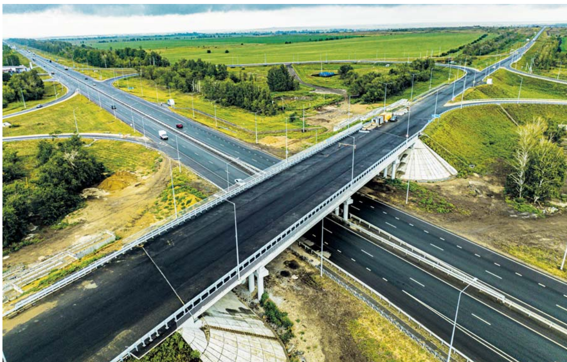
Реконструкция М-5 км 1034 – км 1042 Самарская область
