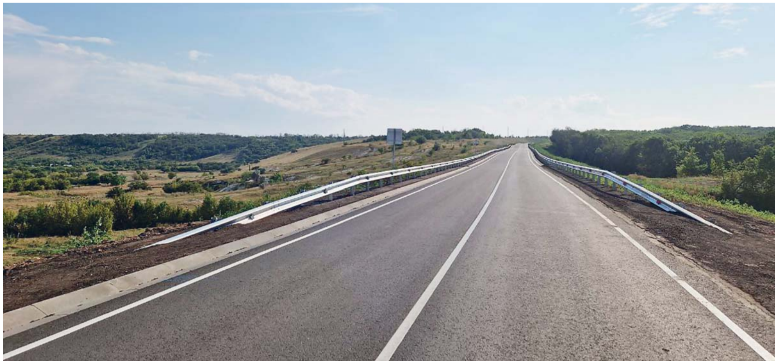
В сезоне 2023 года в ЛНР были капитально отремонтированы 180 км дорог
