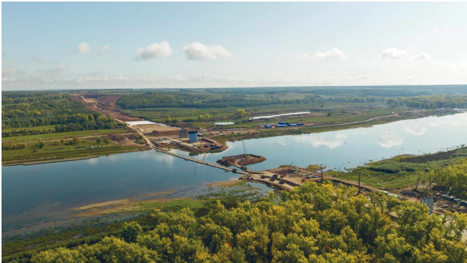
На участке Дюртюли – Ачит протяжностью 275 км продолжаются работы на искусственных сооружениях
