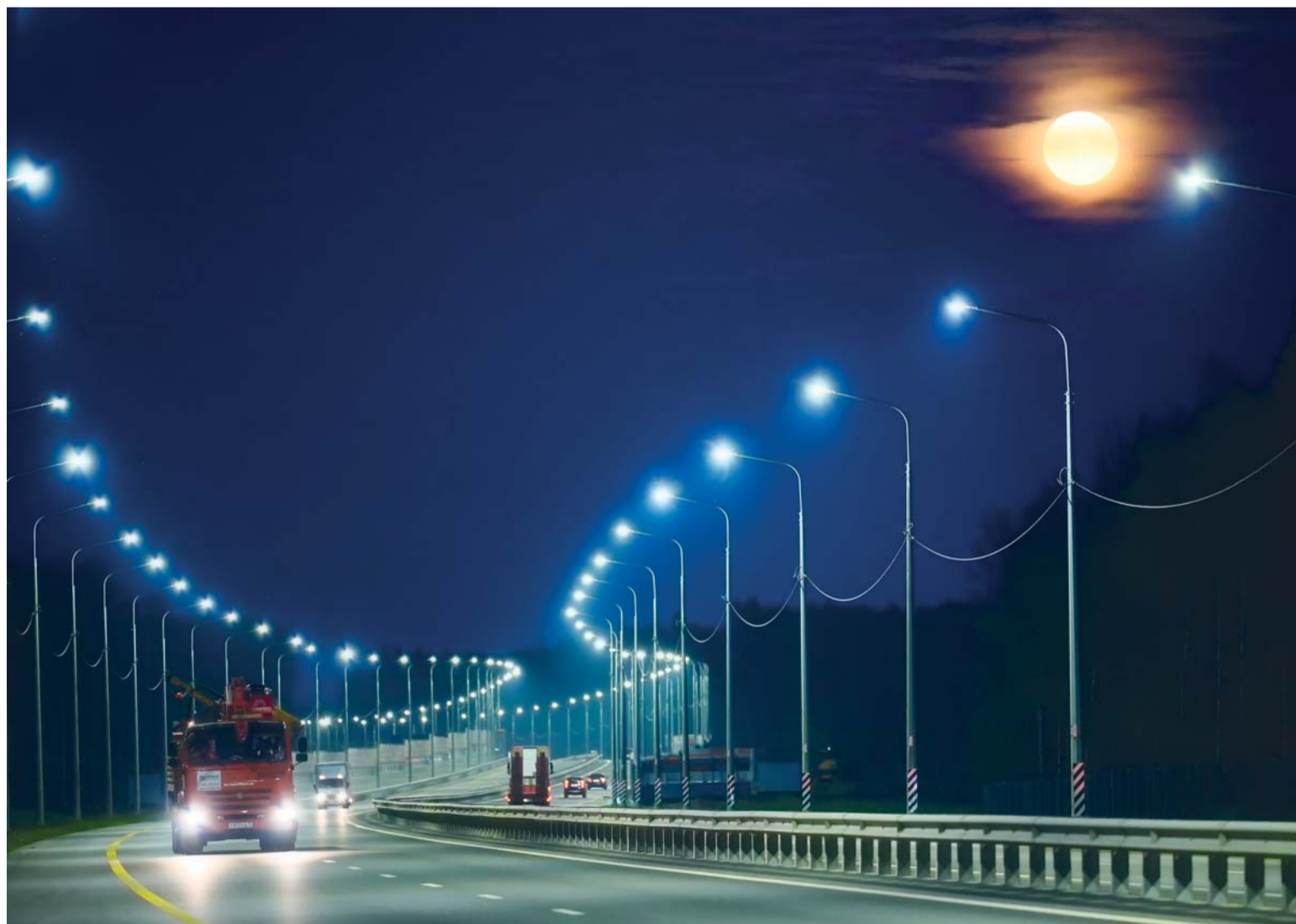
На всем протяжении М–12 «Восток» установлены шумозащитные экраны и опоры искусственного электроосвещения
