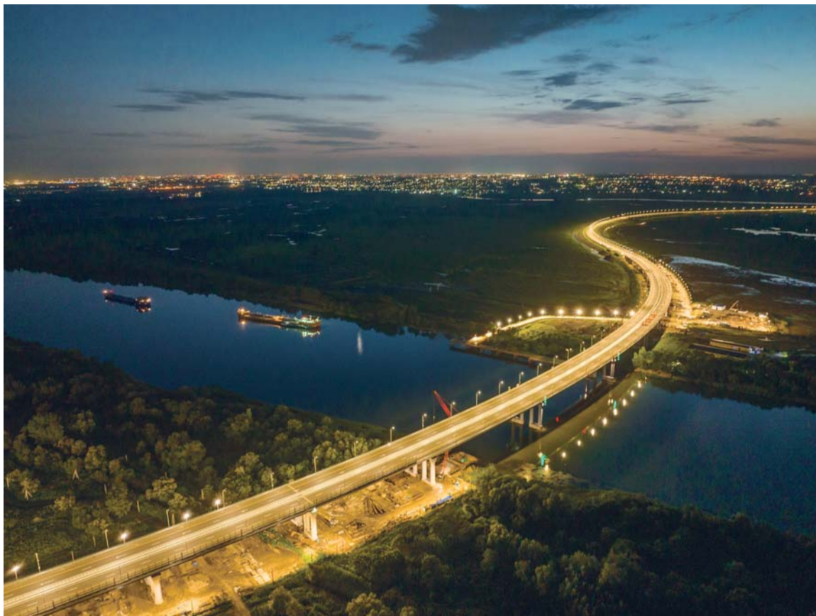
Строительство обхода Ростова-на-Дону было завершено в рекордно короткие сроки – на 18 месяцев раньше запланированного
