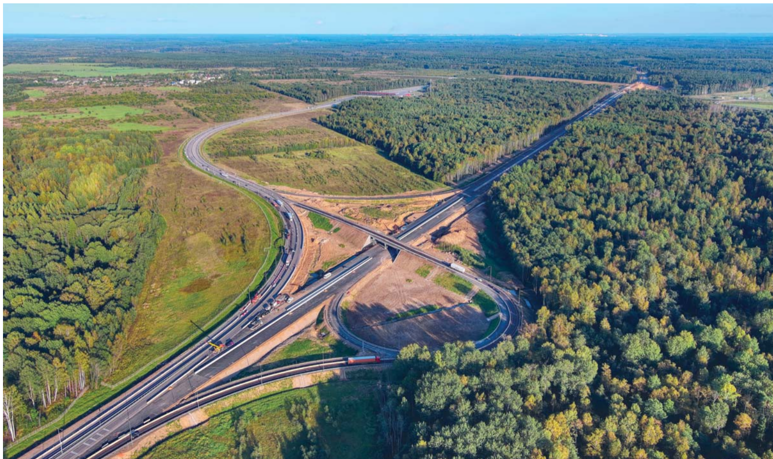
В настоящее время в активной фазе находится строительство северного обхода Твери
