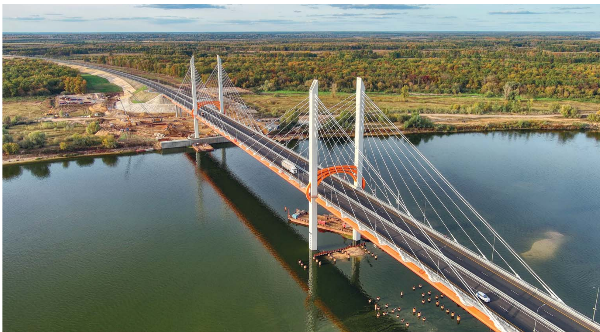
Одним из знаковых и самых сложных инженерных сооружений участка М-12 от Москвы до Арзамаса стал вантовый мост через реку Ока в районе города Муром
