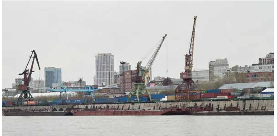
В области необходимо обеспечить регулярный мониторинг и поддержание состояния водных путей для целей судоходства
