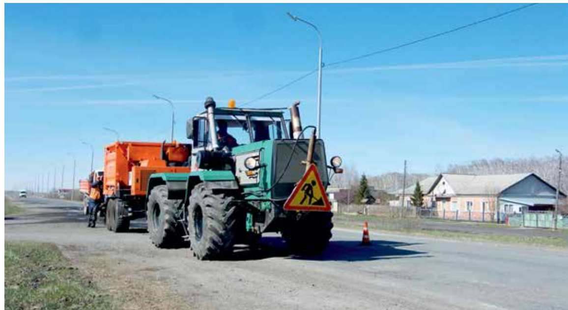
Мечта сельчан – чтобы все дороги в Здвинском районе стали асфальтобетонными
