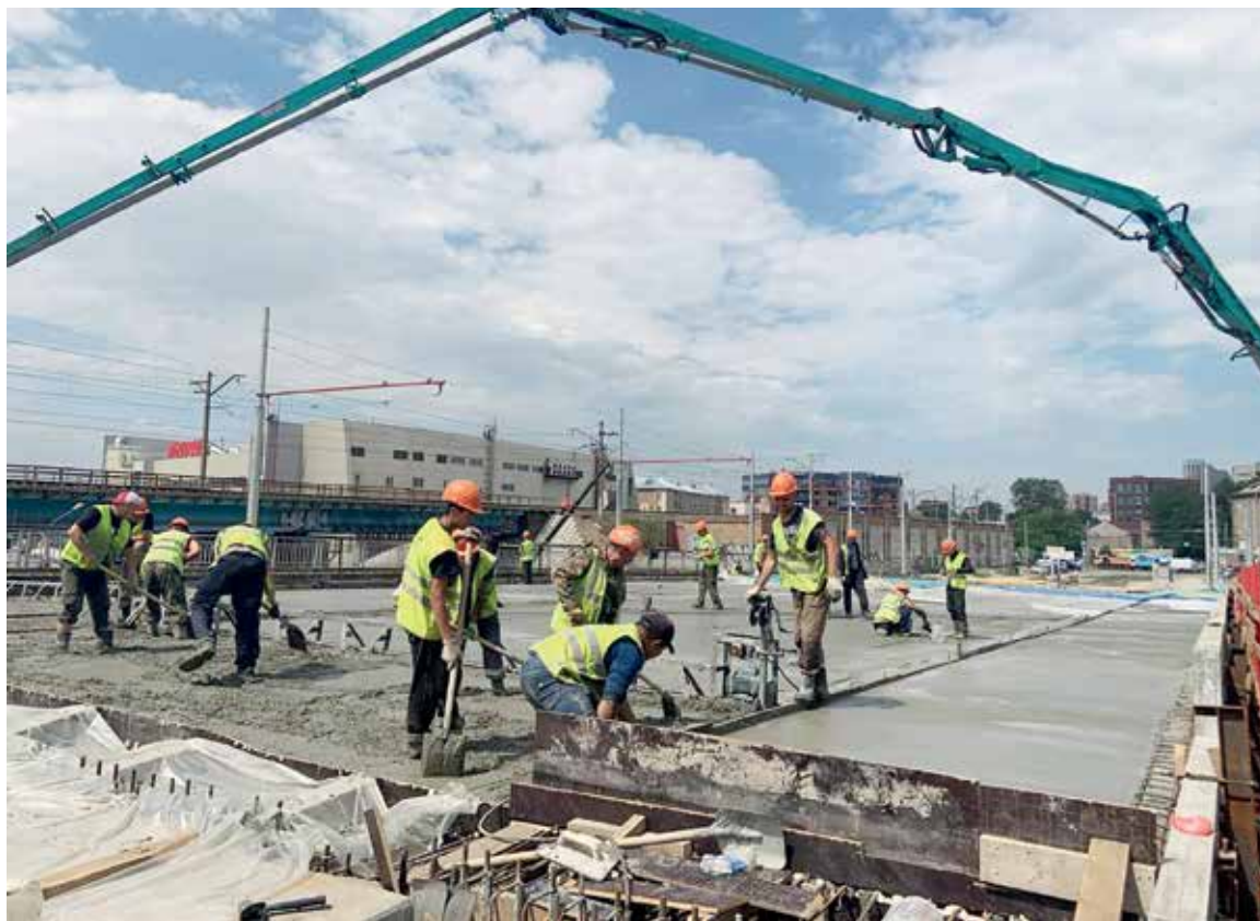
Идут работы на правобережной развязке, на путепроводе на ул. Зырянской в составе четвертого моста
