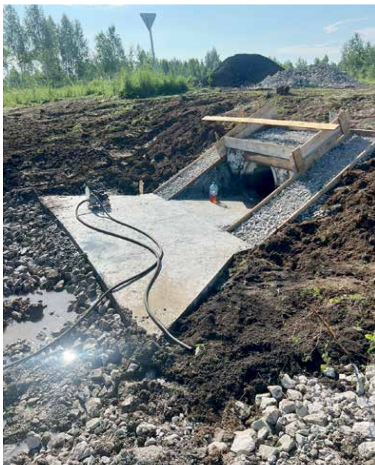
Искусственные сооружения и трубы ремонтируются собственными силами
