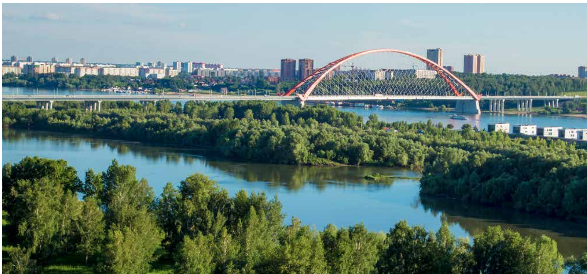
Бугринский мост – третья переправа в Новосибирске, возведенная через реку Обь. Он считается одним из самых масштабных проектов, для реализации которого использовались современные материалы и инновационные методы строительства
