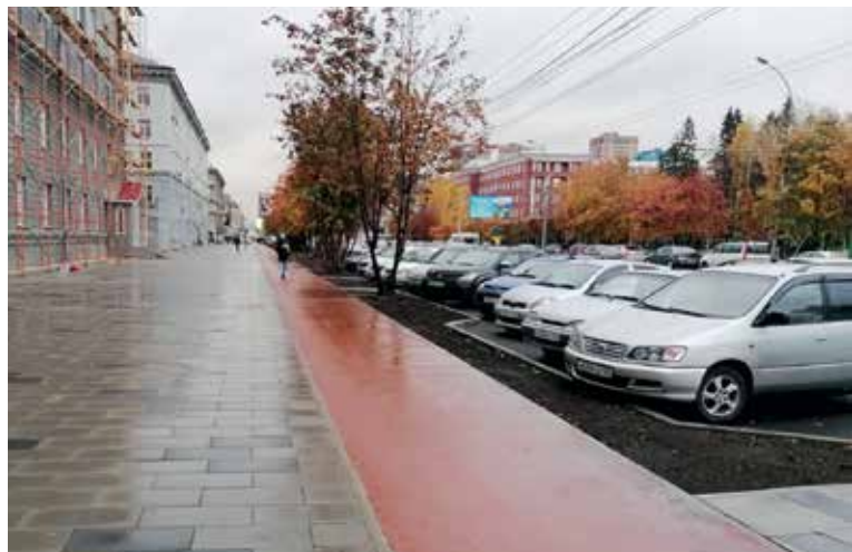
Проспект Карла Маркса в Новосибирске после ремонта, выполненного компанией ООО «Дорсиб плюс»
