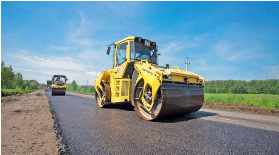
Основные направления деятельности – строительство, реконструкция и ремонт автомобильных дорог, городских улиц и сооружений на них
