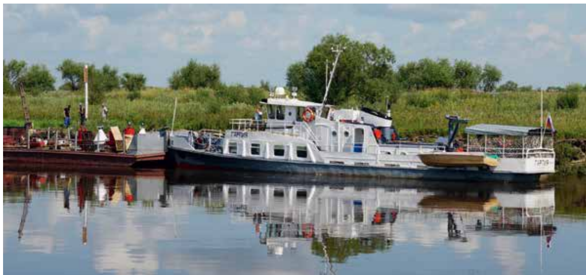
Обстановочный теплоход «Гарпия» при установке створных знаков на реке Зея
