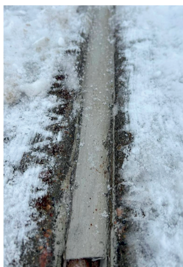
Шов покрытия московского аэропорта Внуково после заливки «холодным» тиоколовым герметиком «Лепта Ъ» спустя 10 лет эксплуатации
