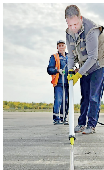
Устройство «Мушкет-11» на заливке швов аэродромных покрытий
