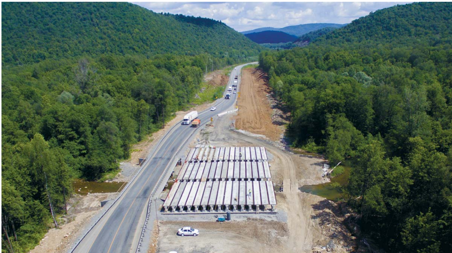
Строительство и реконструкция федеральной автодороги М-5 «Урал»
