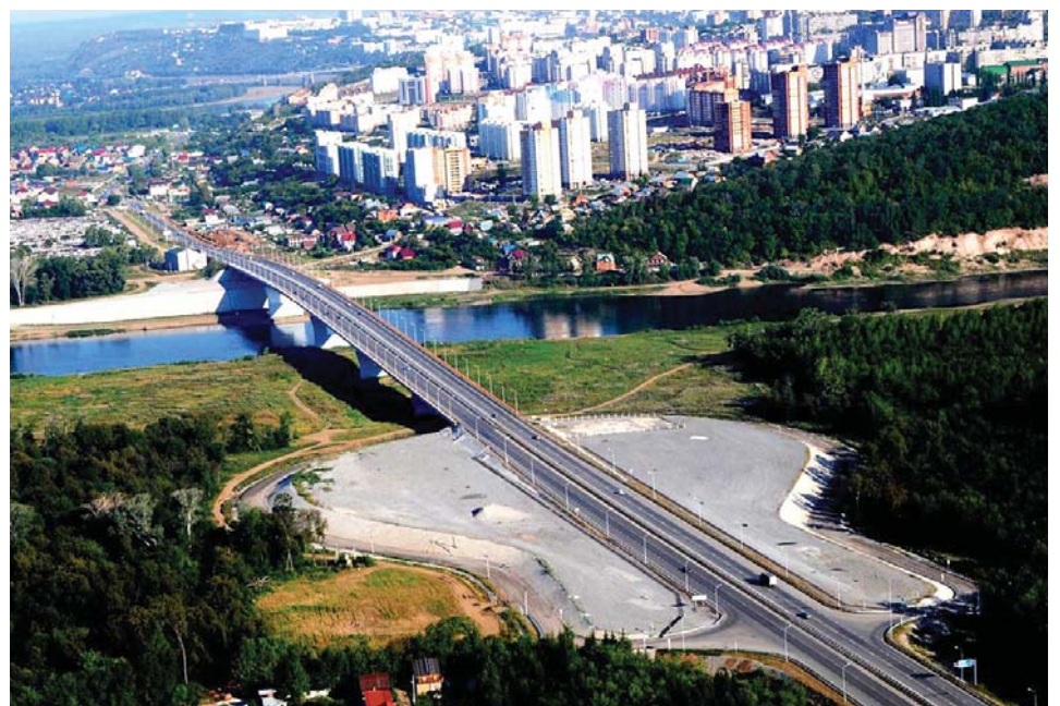
Мост через р. Уфа в районе Каменная переправа
